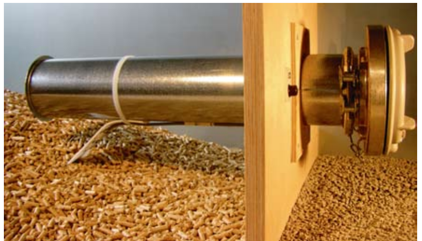
Eine Sonde am Einfüllstutzen misst den Füllstand des Lagers und gibt per Funk ein Signal an den Liefer-LKW, wenn das Lager voll ist.
